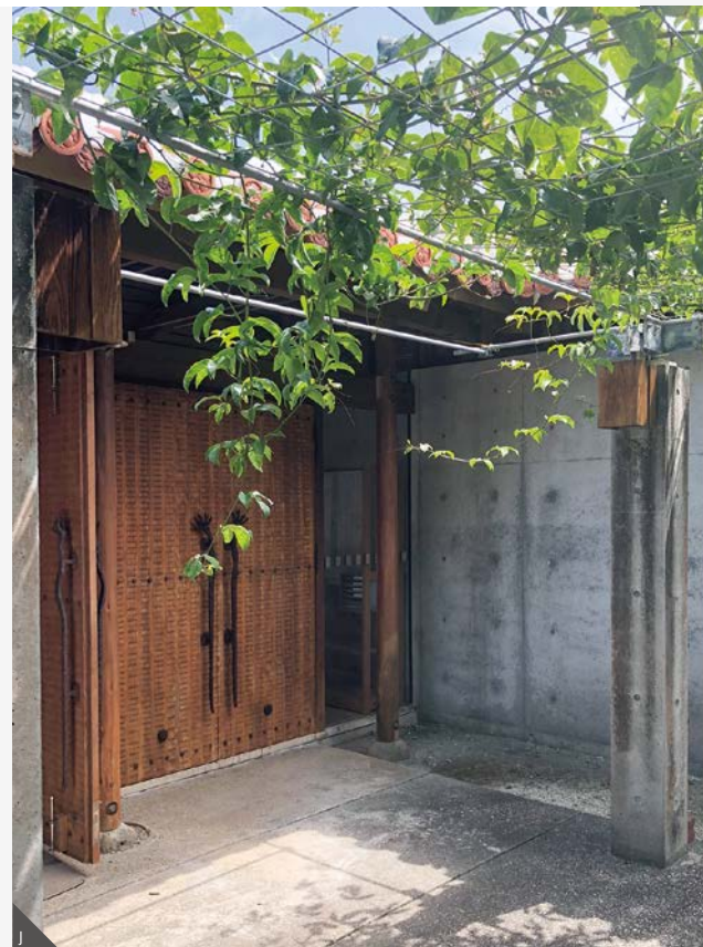
J. しらほサンゴ村 / (有)うえざと木工 WWFジャパンが沖縄県石垣市に設立したWWFサンゴ礁保護研究センター。外部建具にアコヤが使用されています。
