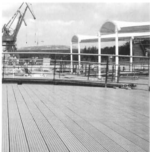
⑦上海万博の棧橋デッキ
