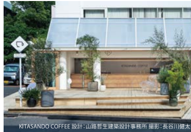
KITASANDO COFFEE 設計: 山路哲生建築設計事務所 撮影: 長谷川健太
