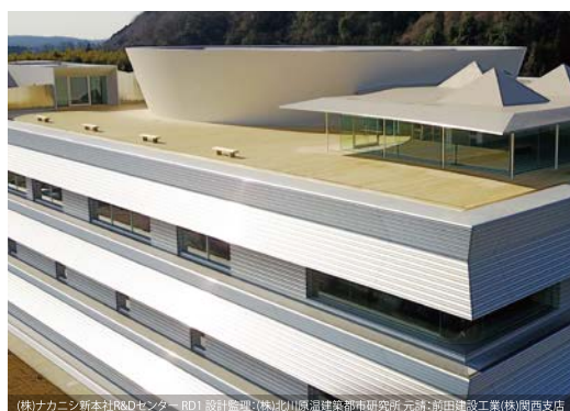
(株)ナカニシ新本社R&Dセンター RD1 設計監理: (株)北川源建築都市研究所 元請: 前田建設工業(株)関西支店
