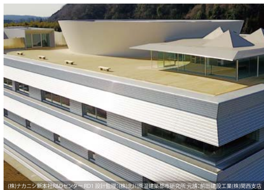
(株)ナカニシ新本社R&Dセンター RD1 設計監理:(株)北川環境建築都市研究所元請:前田建設工業(株)関西支店
