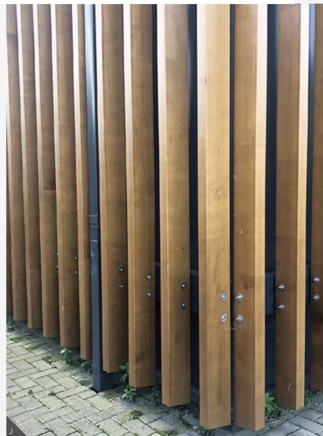
J. Ellesmere Port Sports Village フィットネスクラブのファサード(ルーバー)に使用されています。
